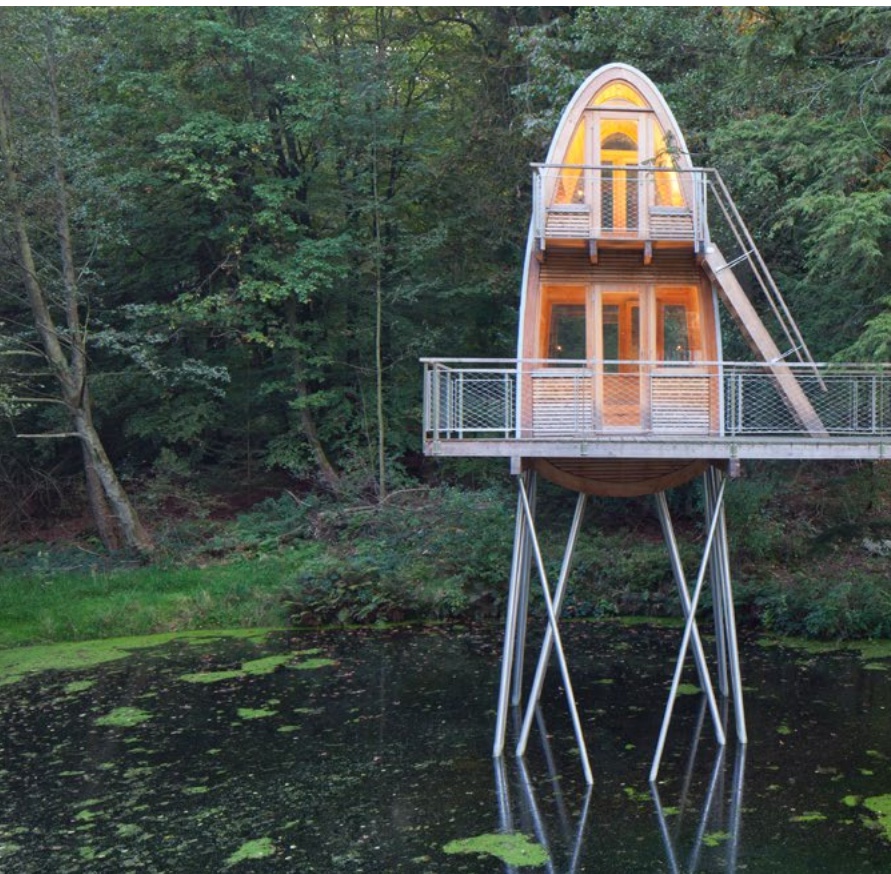
Das doppelstöckige Baumhaus Solling in Niedersachsen steht in einem Teich und erschließt mit Terrassen auf 4,2 und 6,8 Metern Höhe die Kronen der umliegenden Bäume. Die Innenräume bieten elf, die Terrassen 26 Quadratmeter Fläche.
