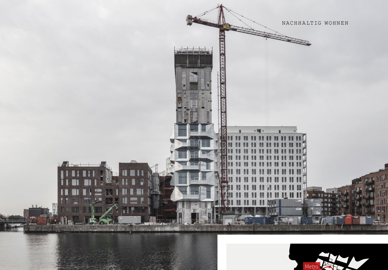
Beim Umbau wurde der Baukörper etwas aufgestockt.
