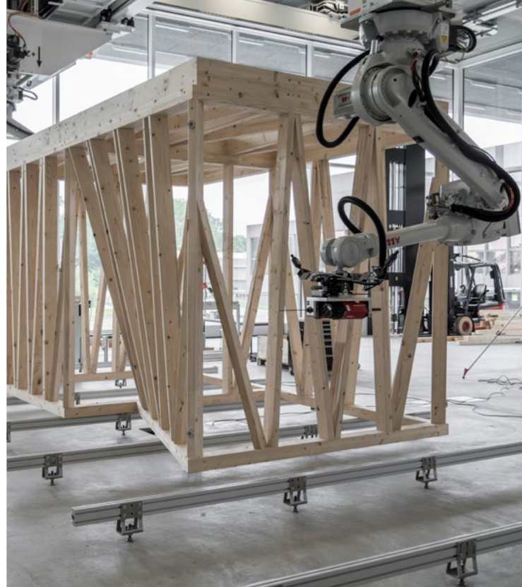
Die Spatial Timber Assemblies, eine Zusammenarbeit zwischen Gramazio Kohler Research, der ETH Zurich und Erne AG Holzbau.
