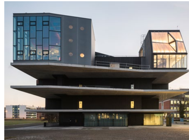
Rechts das DFAB House des Schweizerischen Nationalen Forschungsschwerpunktes (NFS) Digitale Fabrikation.
